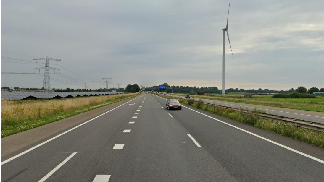
Figuur 5.6 Visualisatie standpunt 2 (regio/veraf), vanaf A15 vanaf A15 bij knooppunt Ressen, kijkrichting oosten. Er is zeer beperkt zicht op een deel van opstelling vanwege de afstand en beplanting. Duidelijk in beeld zijn de windturbines van Windpark Nijmegen-Betuwe langs de A15 en hoogspanningsverbinding.
